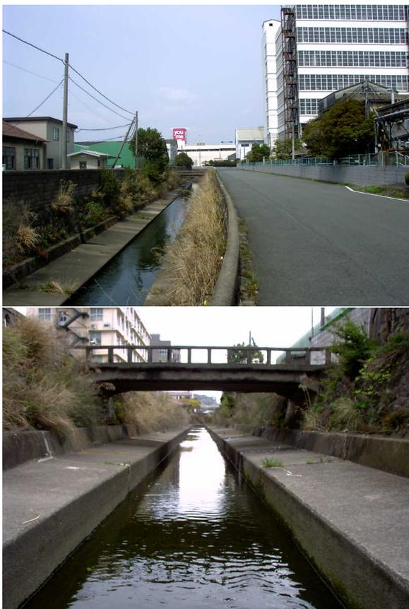
それから25年を経た平成12年、この三面張りの目地から高濃度のダイオキシン類を含んだ油玉が滲み出ているのが発見されました。そのため、緊急に目地の補修工事を行うとともに、福岡県公害専門委員（学識経験者）による大牟田川ダイオキシン対策会議を設置し、汚染原因の究明と対策工法の検討を行ってきました。まずは、汚染の原因究明及び範囲を把握するため平成14年度、平成15年度に河川内のボーリング調査を実施しました。このボーリング調査結果から、河床コンクリートの下方の土壌が最高で49,000 pg-TEQ/gと土壤環境基準（1,000 pg-TEQ/g）の49倍のダイオキシン類に汚染されていることが判明するとともに汚染原因者の推定を行っています。（ちなみにpg（ピコグラム）とは、 $10^{-12}$ g（1兆分の1グラム）です。（東京ドームに相当する入れ物に水を満たして角砂糖1個（1g）を溶かした場合の水1ccに含まれている砂糖の量が1pgになります。）そして現在、これらの調査結果を基に大牟田川における対策実施に向けて検討を進めています。ダイオキシン類汚染対策のやり方としては、大きく2
