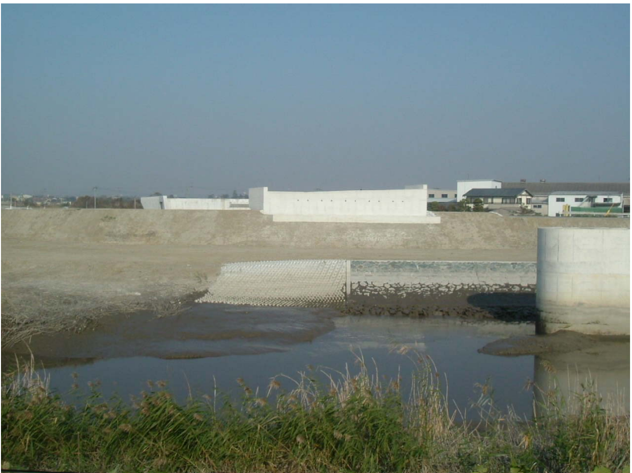
A2橋台施工と上部工架橋を待つ(仮称)柳河橋
