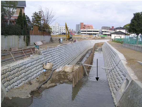
護岸工施工中
