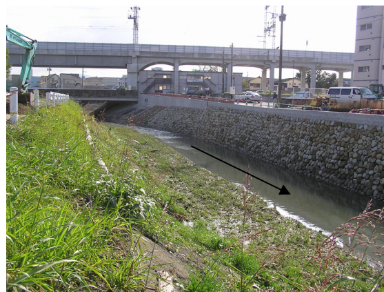
西鉄高架下流側
