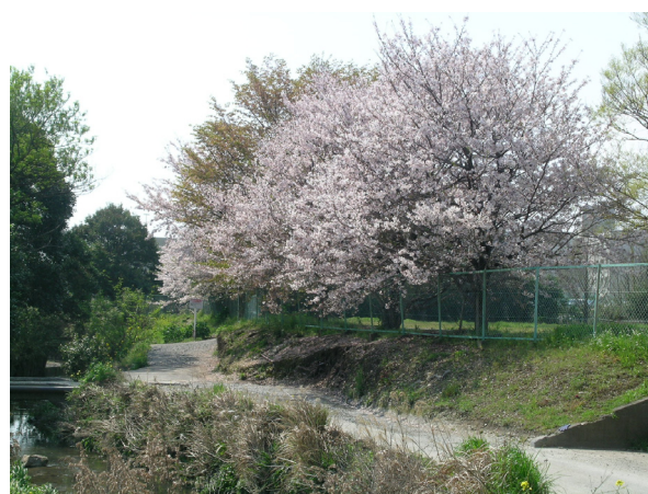
橋梁架替工事箇所
