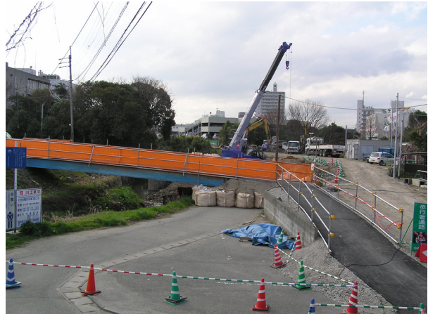
橋梁下部工施工中
