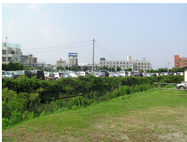
工事着手前金丸川と駐車場
