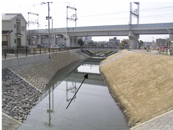
西鉄高架上流側
