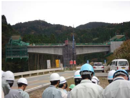
「五ヶ山ダム 5 号橋現場」（那珂川町）
