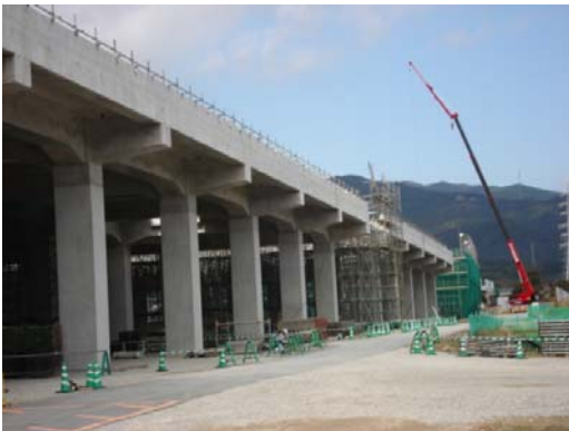
「新幹線高架現場」（鳥栖市）
