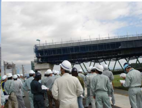
「新幹線筑後川橋梁現場」（鳥栖市）
